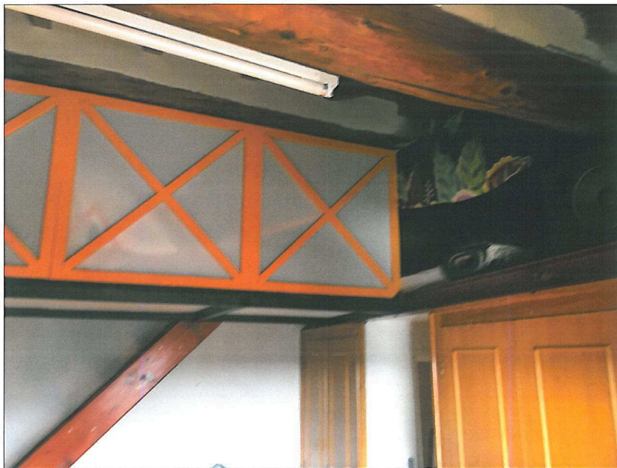
FOTO 14 particolare soppalco abusivo
