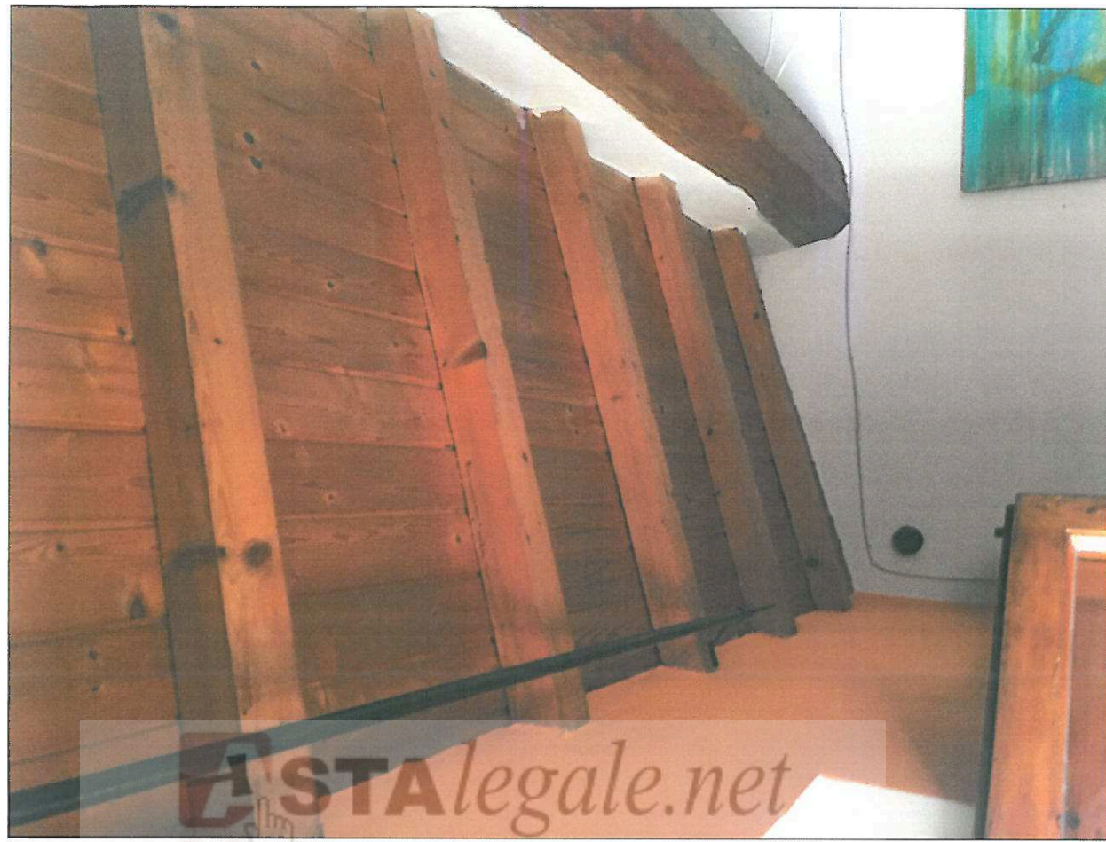
FOTO 16 camera particolare tetto
