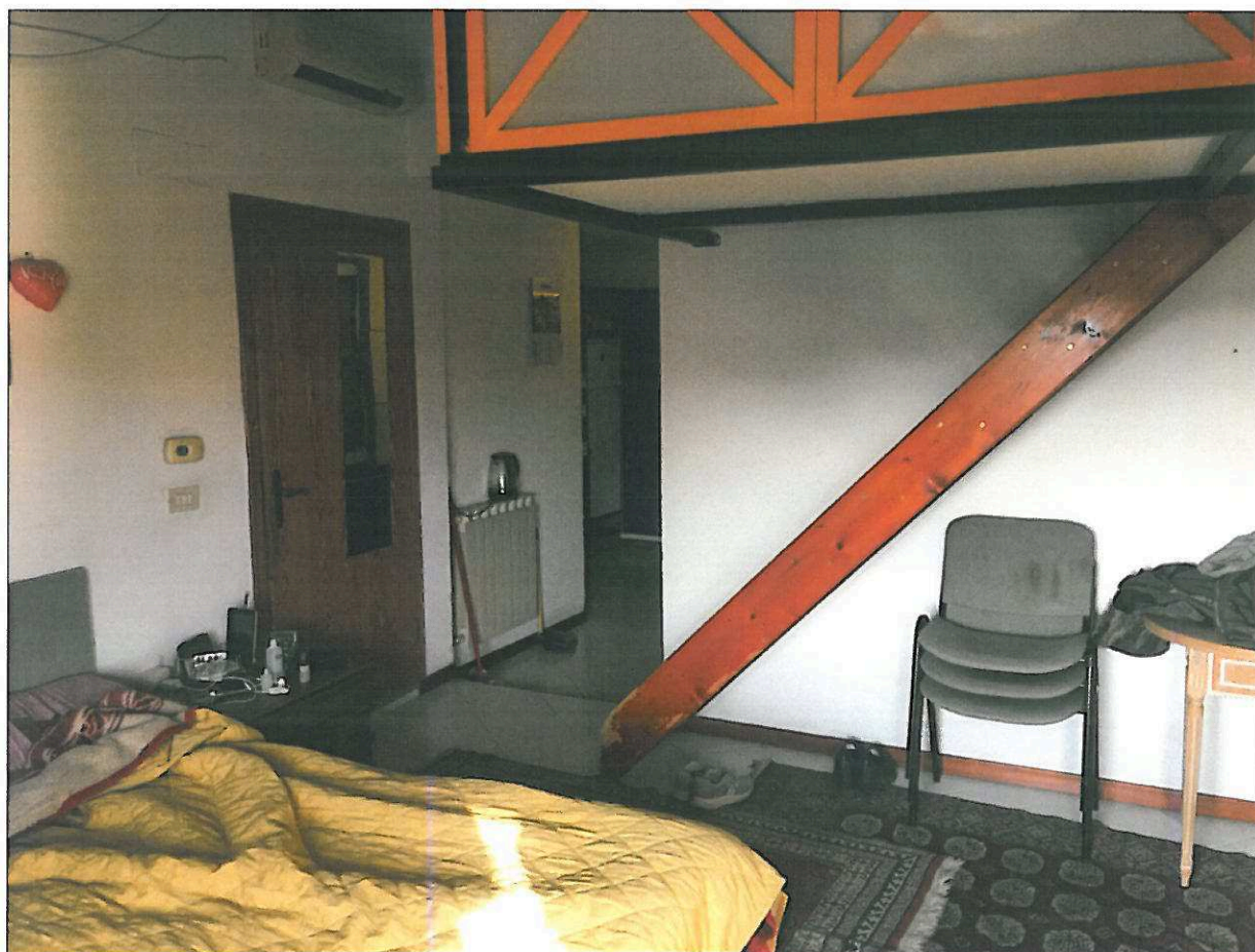
FOTO 12 Camera veduta scala abusiva lato cucina
