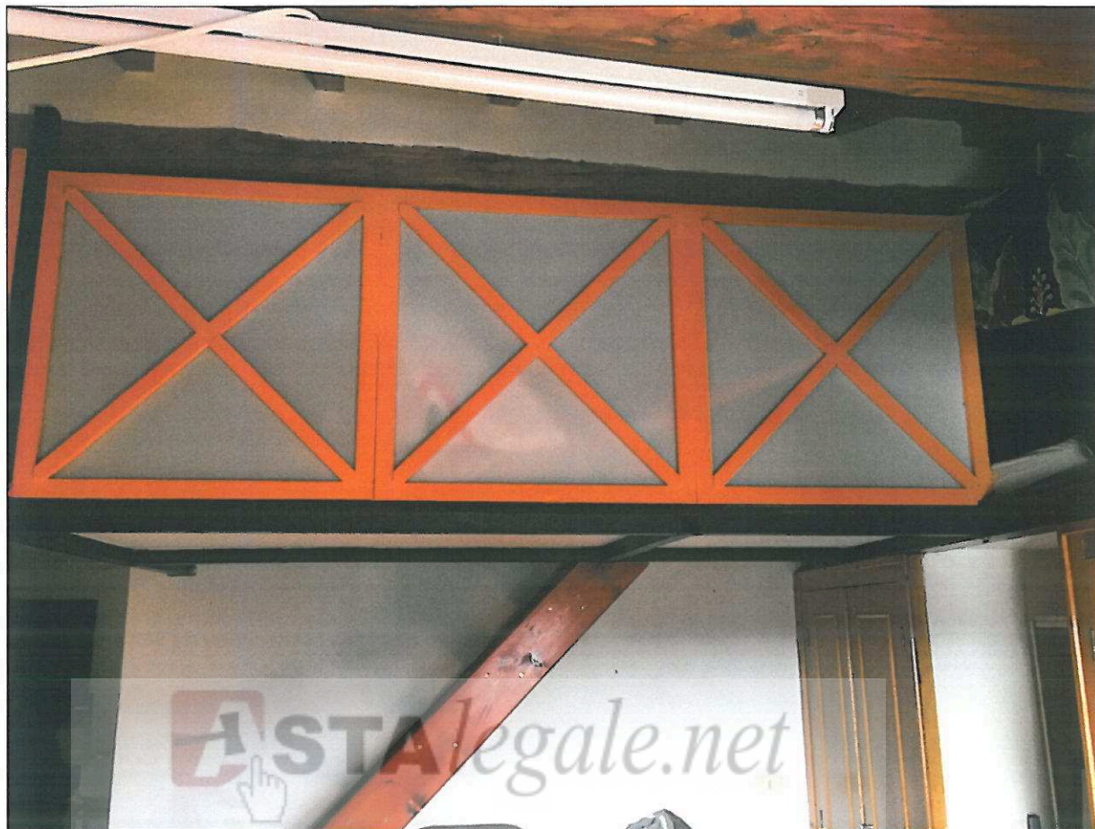
FOTO 13 particolare soppalco abisivo
